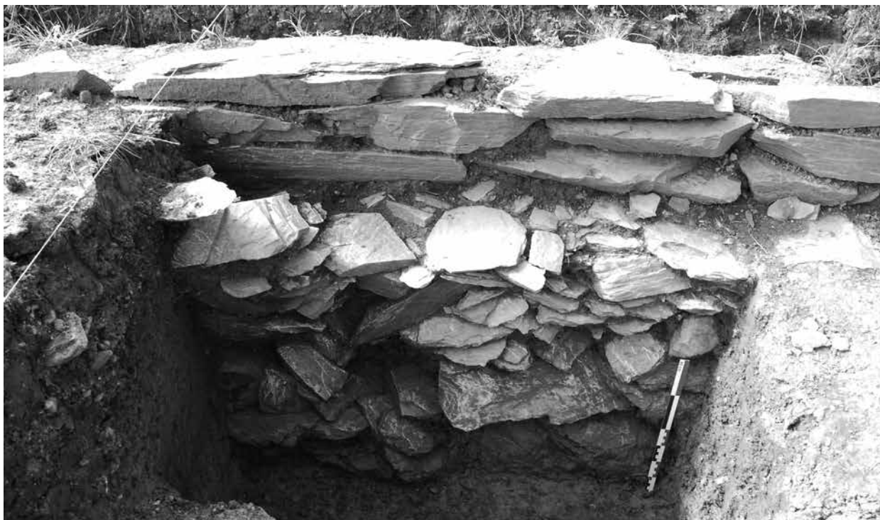
Fig. 5. Mur de clôture sud, fondation et élévation. (Photographie J.-F. Baltus © ARC-HAB).
